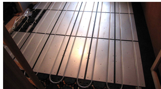
2층 온수온돌판넬 설치
